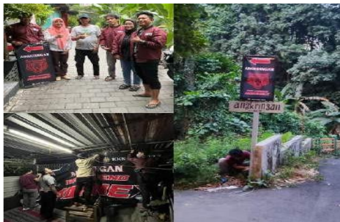
Gambar 3.2.1 Kegiatan pemasangan penerangan jalan akses menuju angkringan
