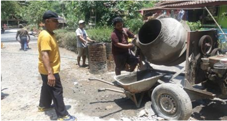
Gbr 3. Kerja Bakti Pengerasan Jalan Akses Menuju Goa Kebon
