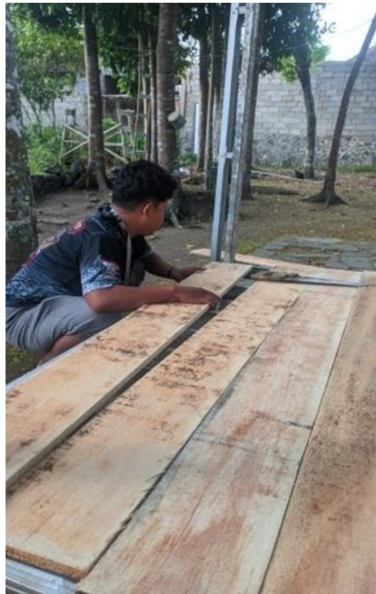
Gambar 3. Proses Pemasangan Papan untuk Gazebo
