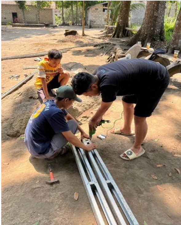
Gambar 1. Proses Pembuatan Rangka Dasar Gazebo
