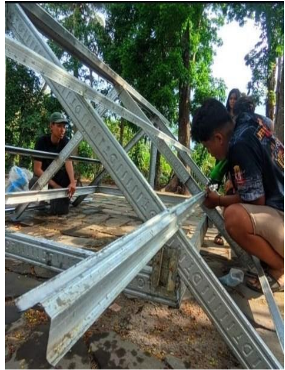
Gambar 2. Proses Pembuatan Rangka Atap Gazebo
