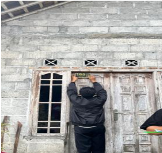
Gambar 5. Pemasangan nomor rumah menggunakan media papan akrilik
